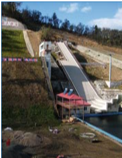
■ Auch die Freeski-Anlage nähert sich der Fertigstellung
