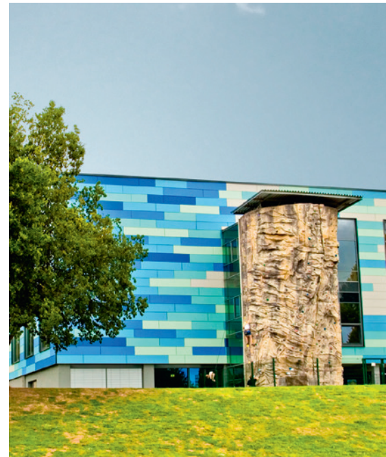
Energetische Sanierung in Göttingen
